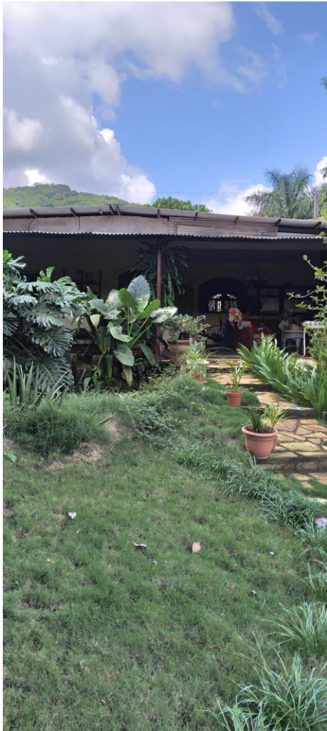
Ilustración 1 Vista de fachada Este
