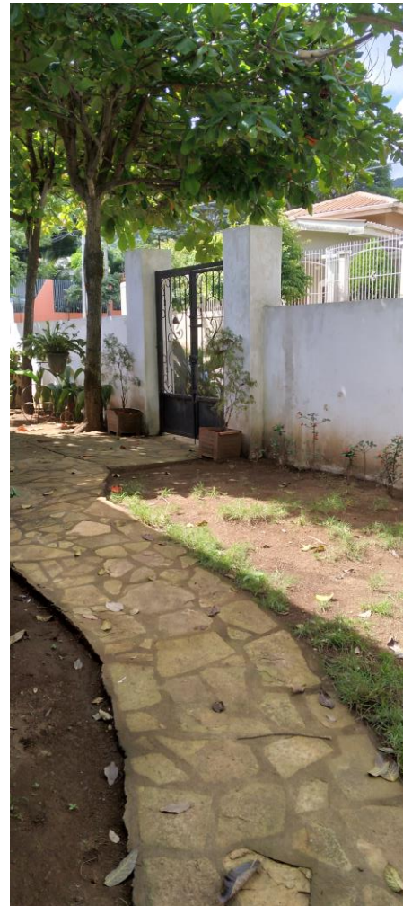
Ilustración 4 Muro Oeste (fachada)
