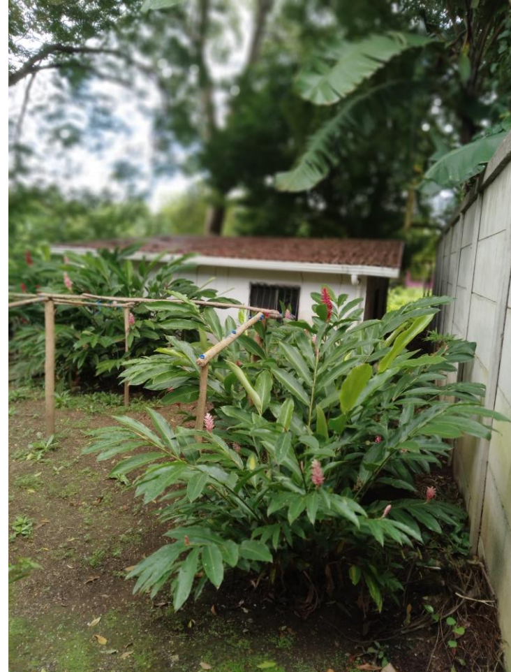
Ilustración 2 Detalle de Muro Sur
